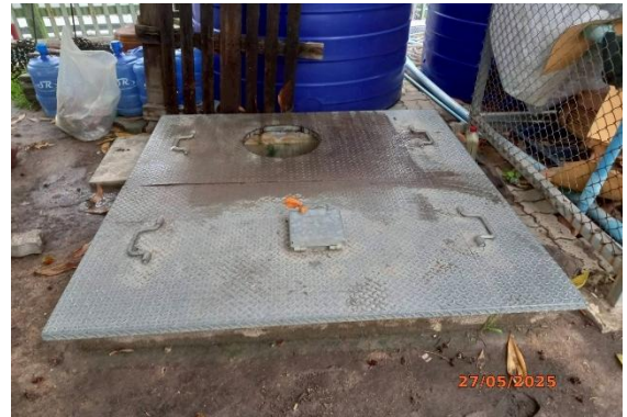
รูปที่ 22 บ่อตรวจสอบคุณภาพน้ำ (Inspection Pit) บริเวณท่อระบายน้ำเสีย
