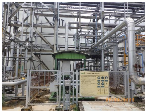
รูปที่ 46 ระบบก๊าซไนโตรเจน (Nitrogen Blanketing)
