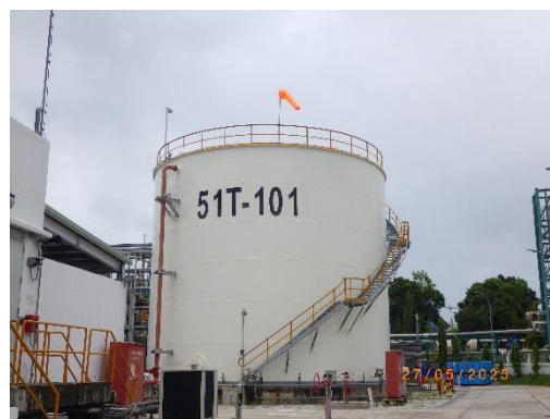
รูปที่ 54 ถังเก็บน้ำใส (Clarified Water Tank)
