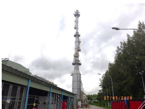
รูปที่ 2 ระบบกำจัดสารอินทรีย์ระเหยแบบ Thermal Oxidizer (TO)
