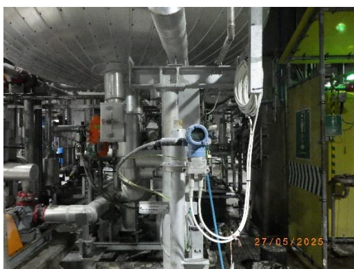
รูปที่ 63 ระบบวัดอุณหภูมิและความดันภายในถังปฏิกริยาโพลีโอลชนิด PPG (PPG Reactor)
