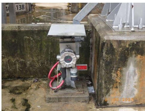
รูปที่ 62 อุปกรณ์ตรวจจับก๊าซ (Gas Detector)
