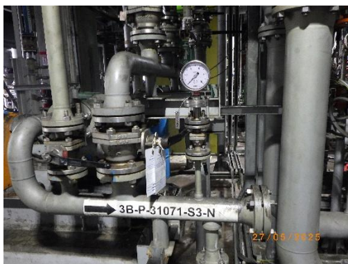
รูปที่ 61 ระบบ Isolate Valve บริเวณอุปกรณ์สูบลำ
