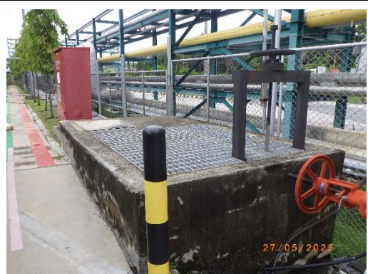
รูปที่ 28 บ่อตรวจสอบคุณภาพน้ำ (Inspection Pit) บริเวณรางระบายน้ำ
