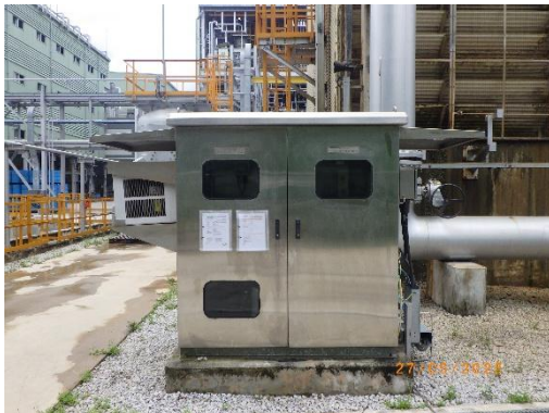
รูปที่ 23 อุปกรณ์ตรวจวัดคุณภาพน้ำเสียอัตโนมัติ ในบริเวณหอหล่อเย็น
