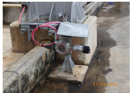
รูปที่ 59 อุปกรณ์วัดระดับ (Level Indicator) ของสารเคมีในถังเก็บ และสัญญาณเตือน (Level Alarm)
