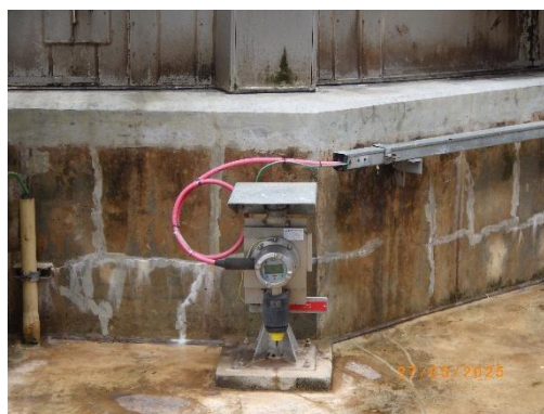
รูปที่ 50 Toxic Gas Detector บริเวณอุปกรณ์การผลิต ที่เกี่ยวข้องกับเอทิลีนออกไซด์
