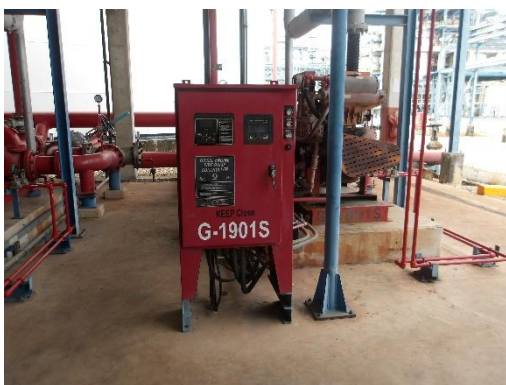
รูปที่ 53 เครื่องสูบน้ำดับเพลิง (Electric Motor Driven Fire Water Pumps)
