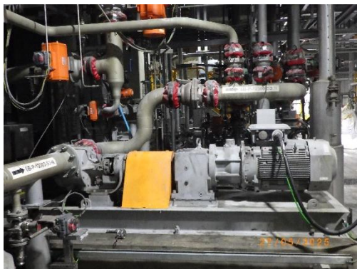
รูปที่ 7 ปัมระบบป้องกันการรั่วไหลสองชั้น (Double Mechanical Seal)
